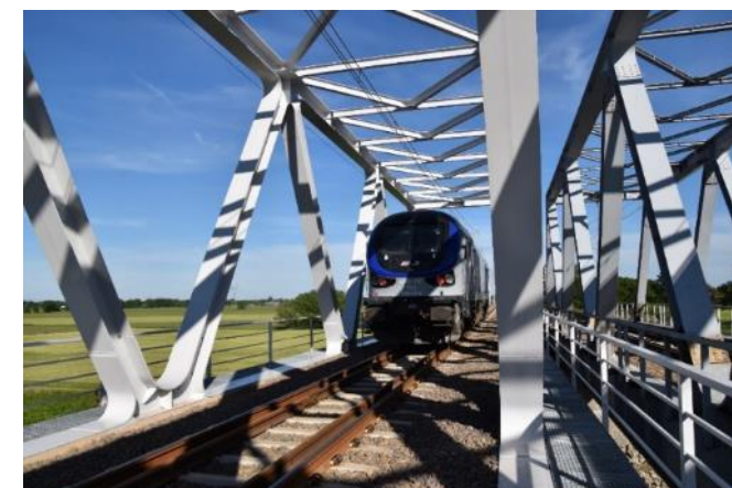
Most na Kanale Grójeckim, E 20
