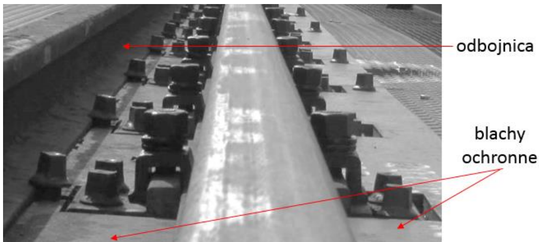
Rys. 11 Środki przeciwdziałające skutkom wykolejenia (przykładowe rozwiązanie)
