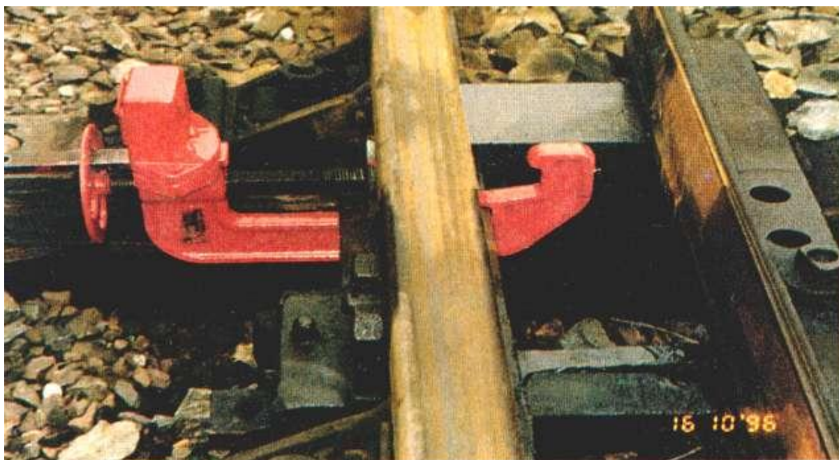
rys. 4 – iglicę odsuniętą należy zabezpieczyć, gdy zamknięcie nastawcze hakowe lub suwakowe działa prawidłowo
