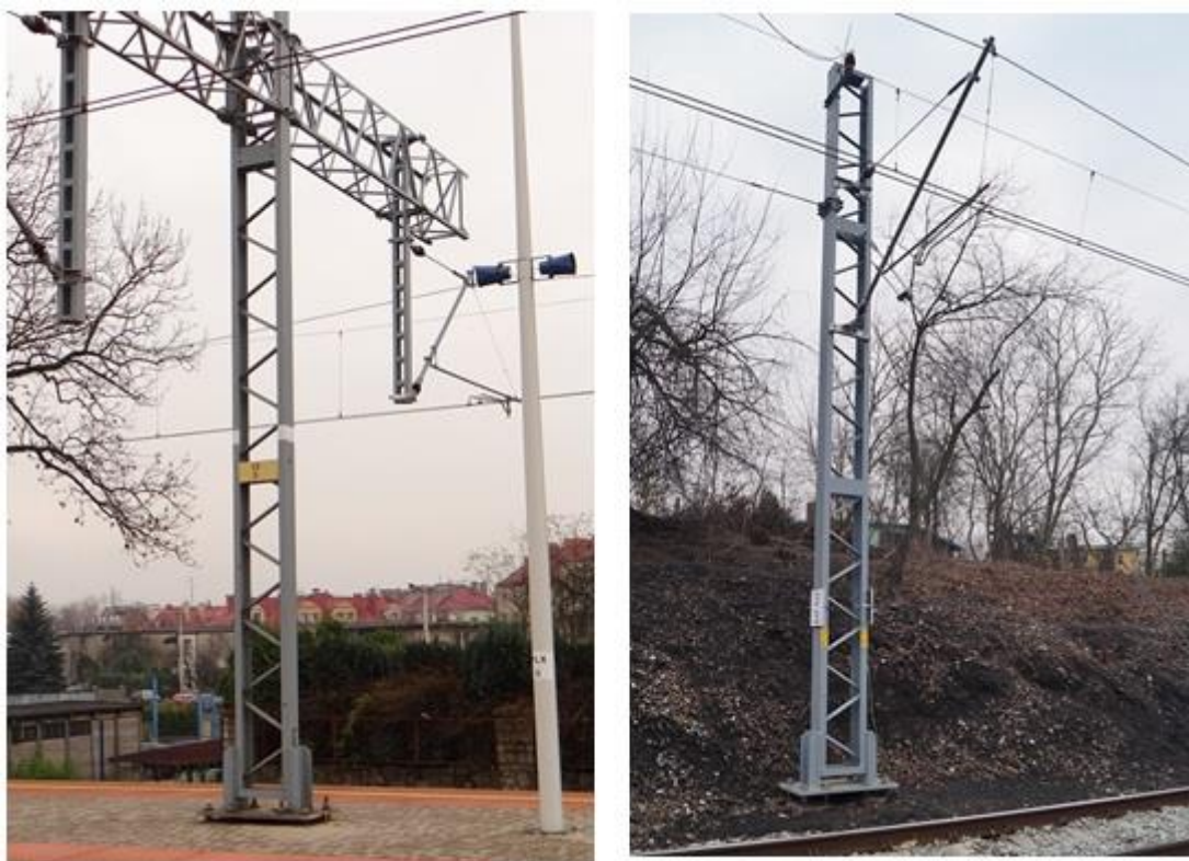
Rys 2.6.3. Drabiniaste konstrukcje wsporcze ułatwiające wspinanie się
