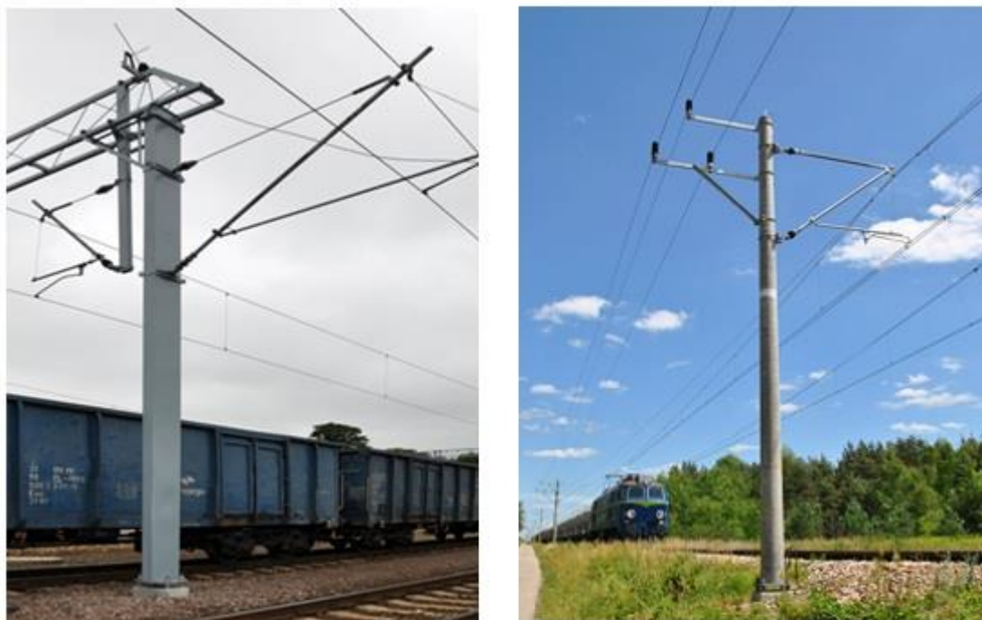
Rys 2.6.4. Gładkopowierzchniowe konstrukcje wsporcze utrudniające wspinanie się
