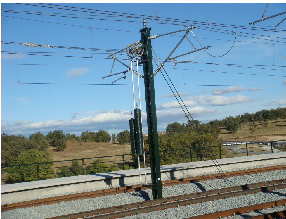
Rys. 10.2.2. Rozwiązanie kotwienia sieci jezdnej linii dużych prędkości Madrid – Valladolid w Hiszpanii.
