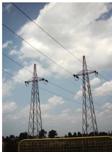
Rys. 6.8.1. Linie 2-fazowe zasilające podstację systemu 1×25 kV AC
