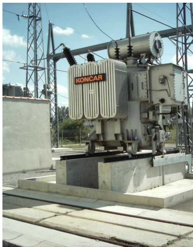
Rys. 6.3.4. Transformator 7,5 MVA
