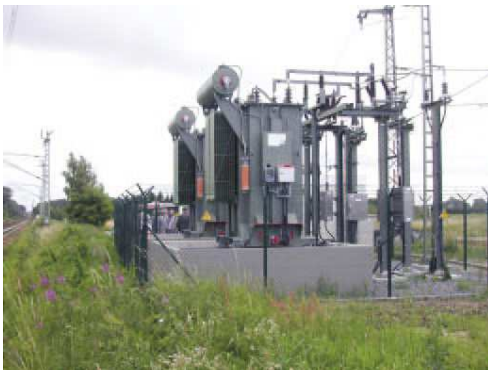
Rys. 6.3.7. Autotransformator 8 MVA
