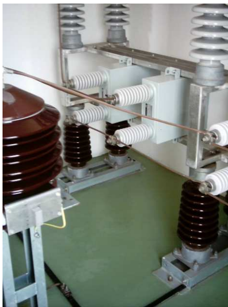
Rys. 6.3.13. Filtr w podstacji 1×25 kV 50 Hz
