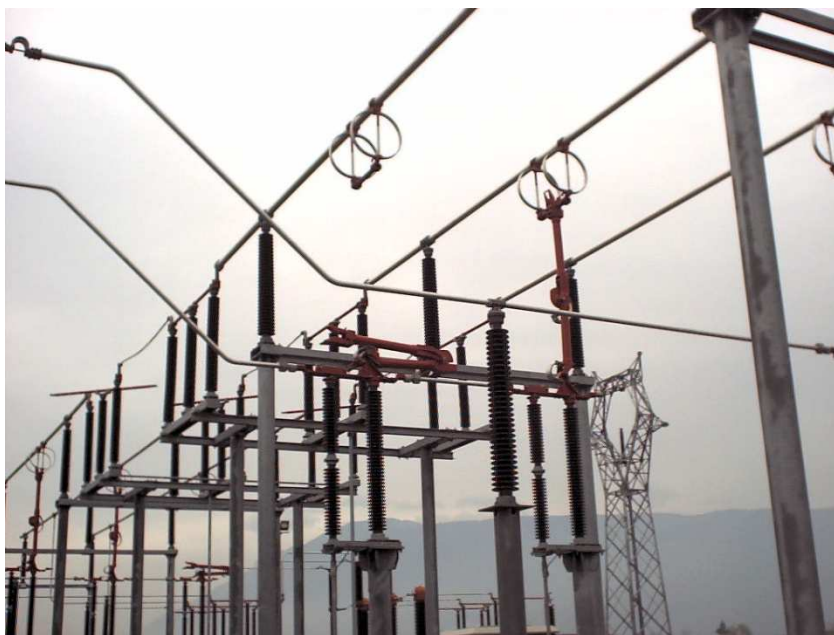
Rys.6.3.2. Rozdzielnia 110 kV
