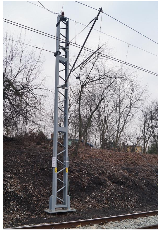
Rys. 2.6.3. Drabiniaste konstrukcje wsporcze ułatwiające wspinanie się
