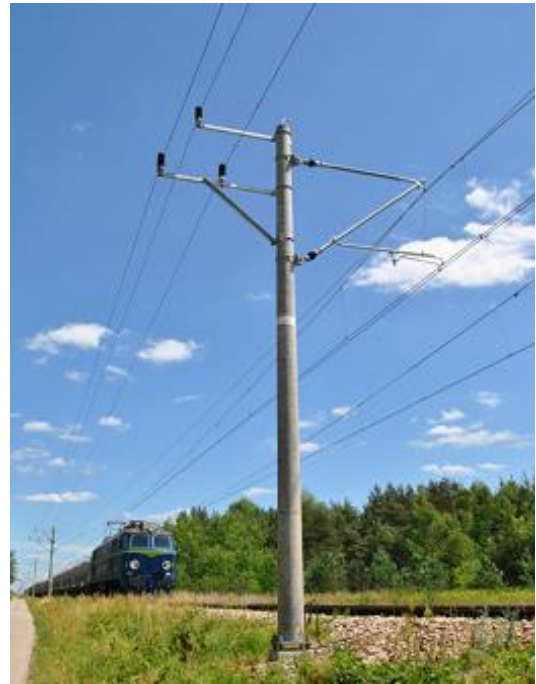
Rys. 2.6.4. Gładkopowierzchniowe konstrukcje wsporcze utrudniające wspinanie się
