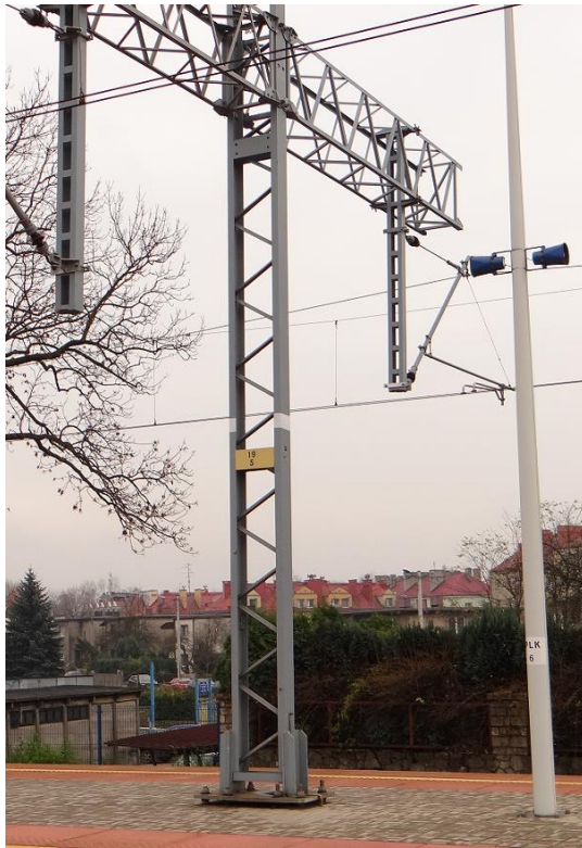
Rys. 2.6.3. Drabiniaste konstrukcje wsporcze ułatwiające wspinanie się
