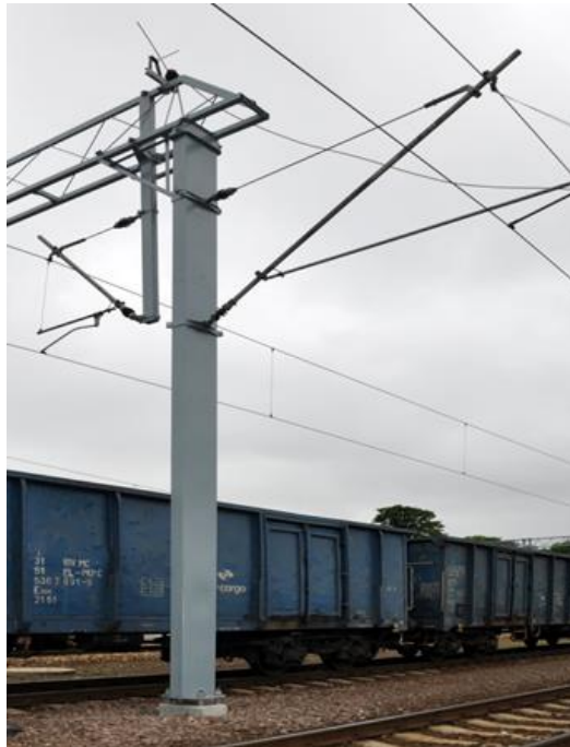
Rys. 2.6.4. Gładkopowierzchniowe konstrukcje wsporcze utrudniające wspinanie się
