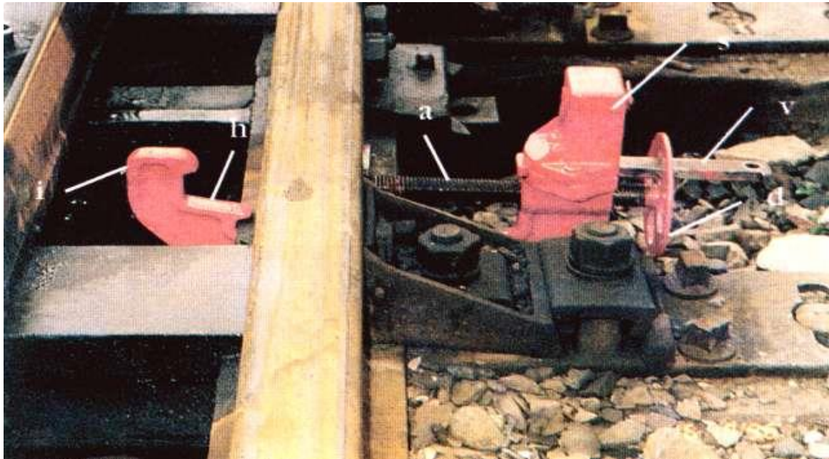
Rys. 2-1 zabezpieczenie iglicy odsuniętej,
