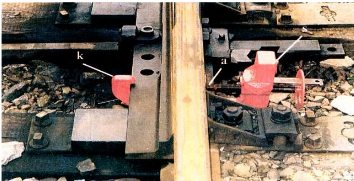
Rys. 2-2 zabezpieczenie iglicy dosuniętej,
