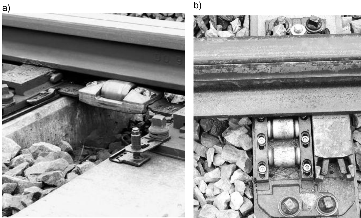
Rys. 1. Przykładowe rozwiązania rolek podiglicowych: a) swobodne, b) zintegrowane
