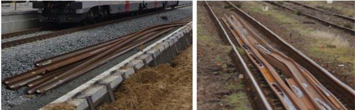
Rys. 2 Błędy w składowaniu szyn [źródło: www.skyscrapercity.com ]
