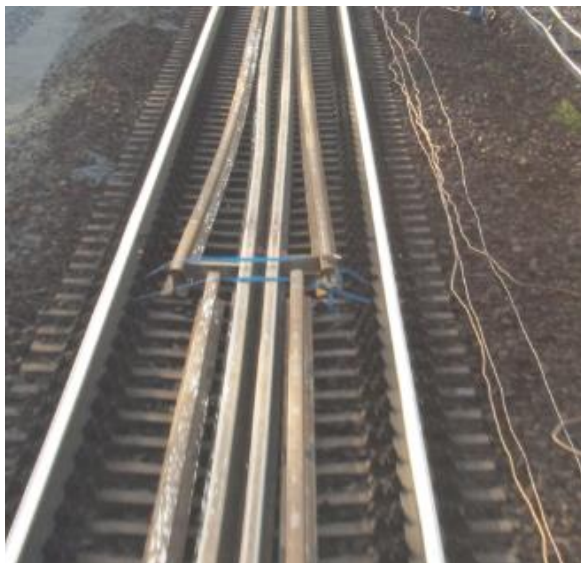
Rys 1. Składowanie szyn na placu budowy: a) do wewnątrz toru, b) na zewnątrz toru [źródło: PKP PLK S.A.]
