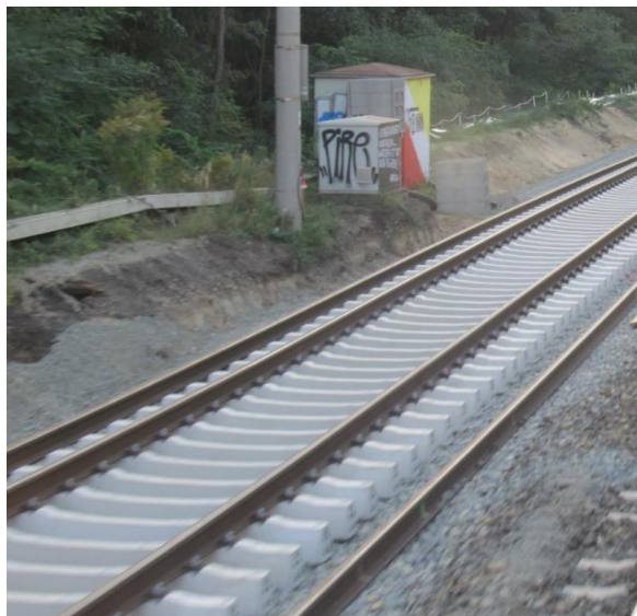
Rys 1. Składowanie szyn na placu budowy: a) do wewnątrz toru, b) na zewnątrz toru [źródło: PKP PLK S.A.]
