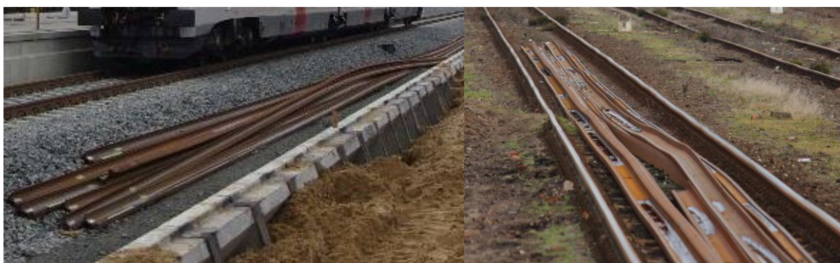
Rys. 2 Błędy w składowaniu szyn [źródło: www.skyscrapercity.com ]
