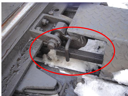
Rysunek 6 Część zamknięcia nastawczego w podrozdniczce zespolonej w okresie zimowym.
