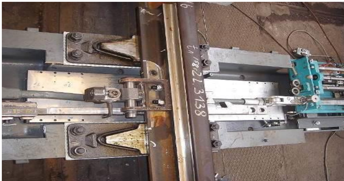
Rysunek 16 Płyta grzewcza PGJ-500 zabudowana w podroczajdnicy zespolonej.
