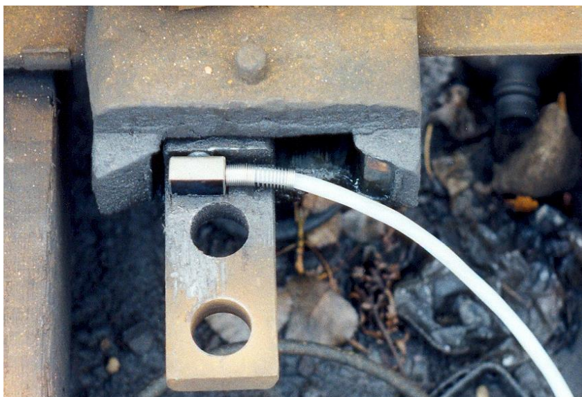
Rysunek 14 Grzejnik zamknięciowy wewnątrzsuwakowy oraz sposób jego montażu.
