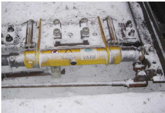
Rysunek 4 Zamknięcie nowego typu – zamknięcie nie wymaga ogrzewania.
