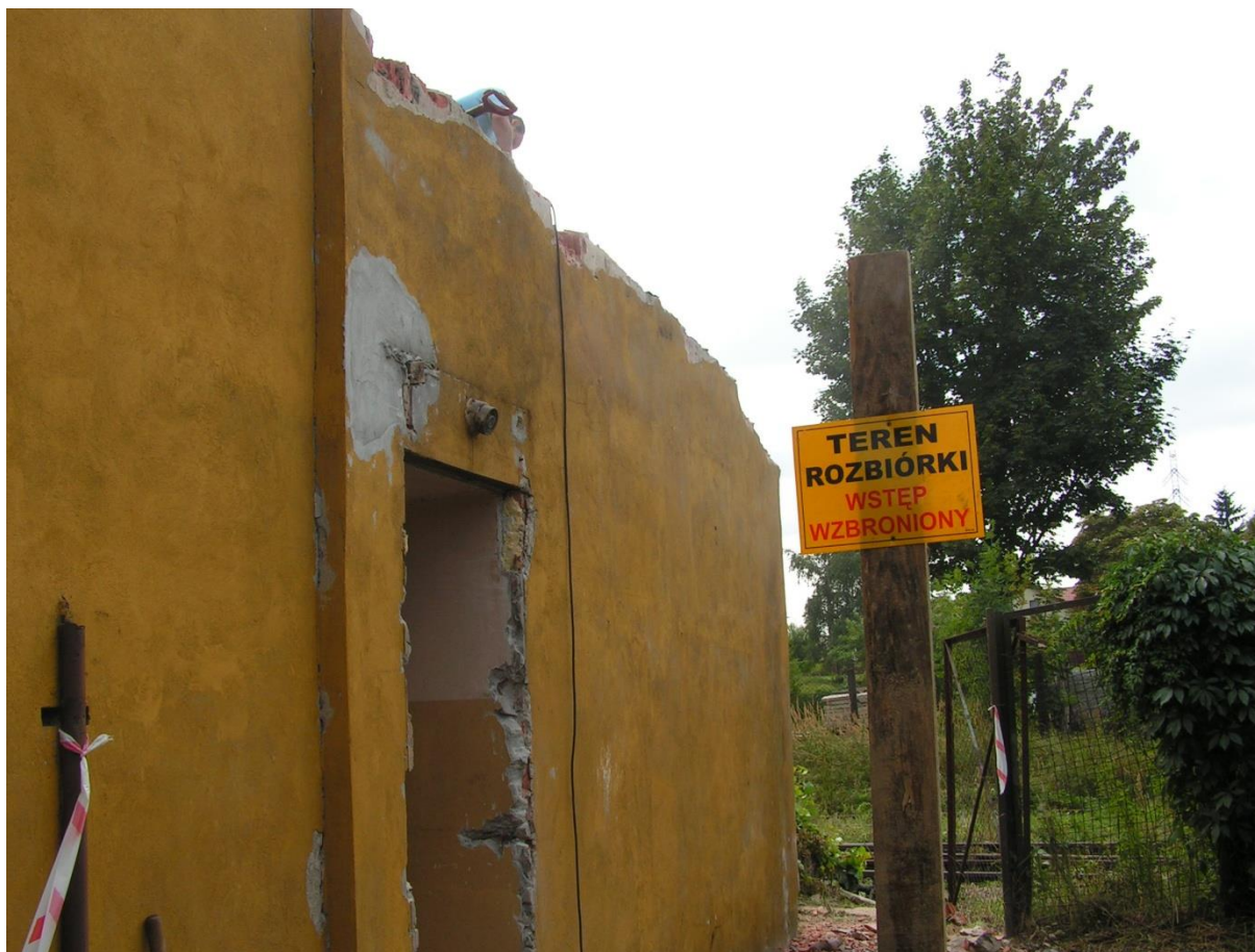
Rys 25 Wyburzanie starej części nastawni
