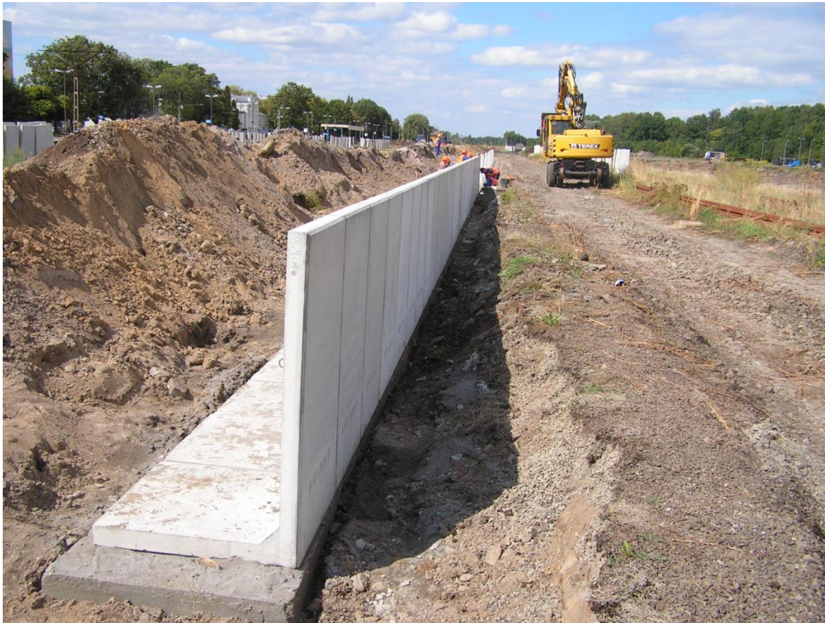
Rys 22 Ustawianie ścianek peronowych
