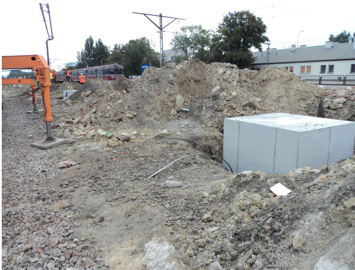
Rys 18 Gotowy oczep pala pod wiatę peronową
