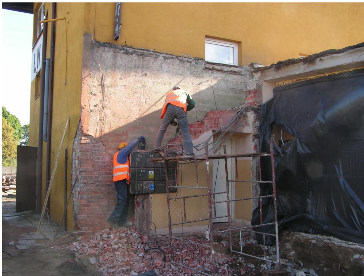
Rys 26 Wyburzanie starej części nastawni
