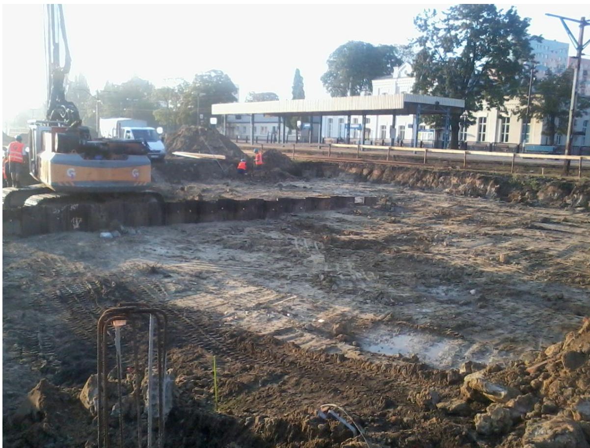
Rys 11 Wykop pod wbijanie ścianek
