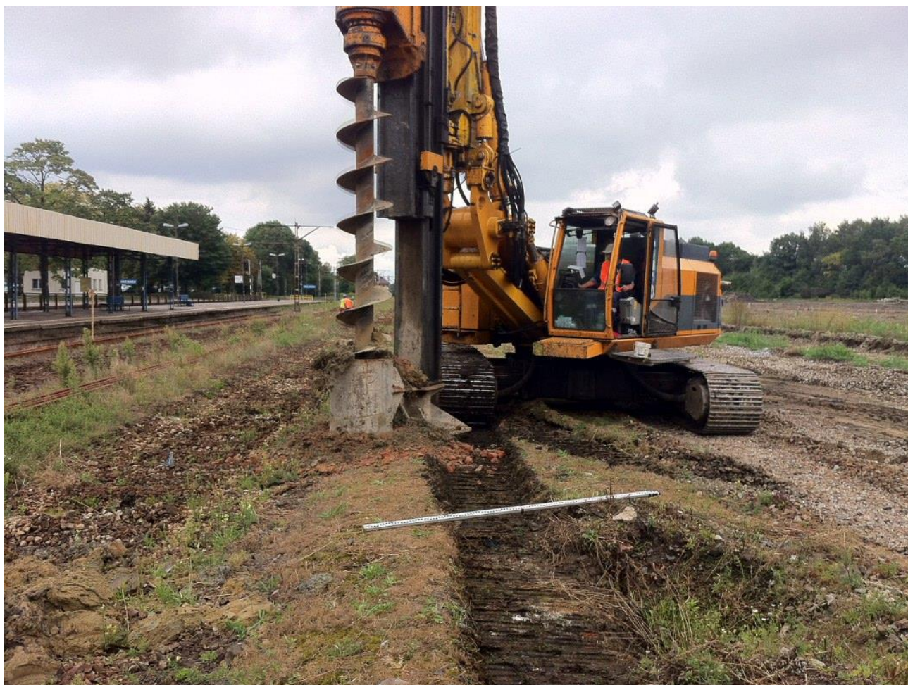
Rys 15 Wykonywanie pali pod wiatę peronową
