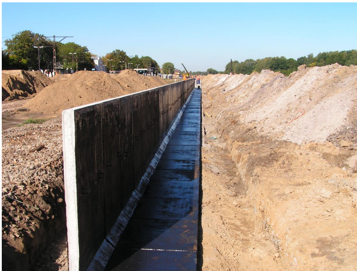
Rys 23 Ustawianie i izolowanie ścianek peronowych
