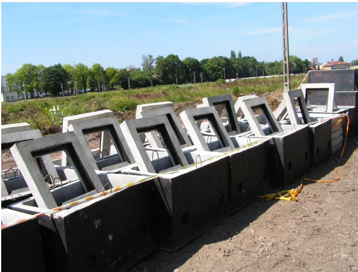
Rys 38 Studnie do budowy kanalizacji teletechnicznej
