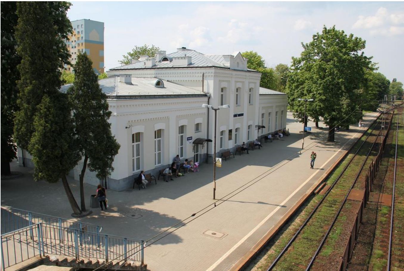
Rys.1 Stacja Łódź Widzew – budynek stacyjny wraz z peronem jednokrawędziowym.
