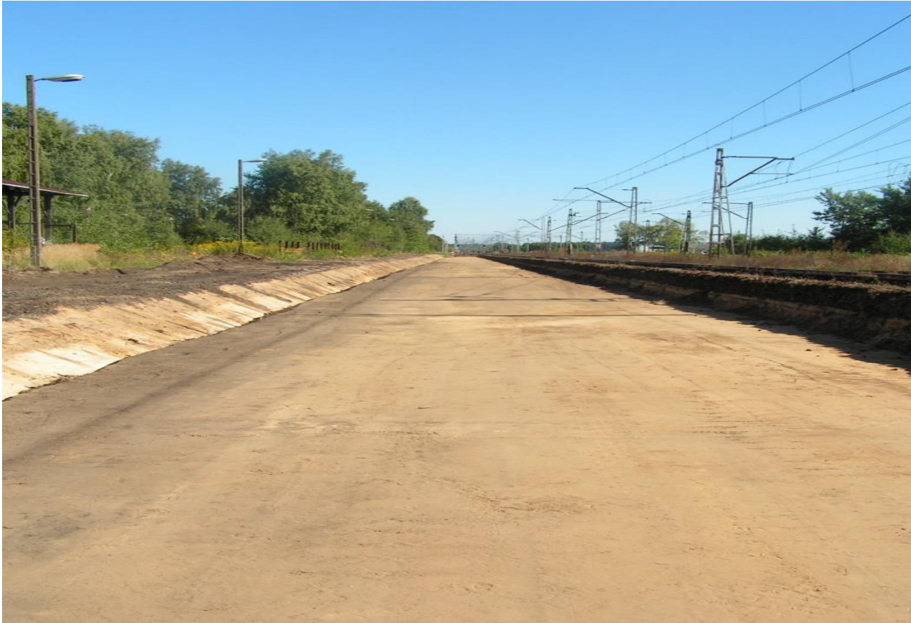
Rys 31 Roboty ziemne - plantowanie
