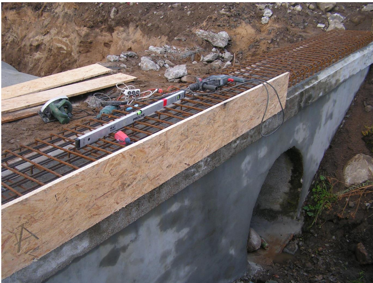
Rys 12 Wykonanie nowych przyczółków i gzymsów
