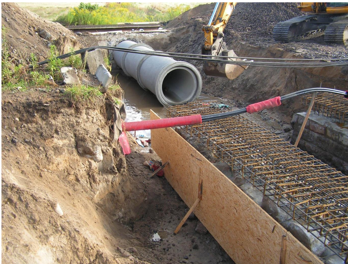
Rys 13 Montaż nowych elementów przepustu rurowego
