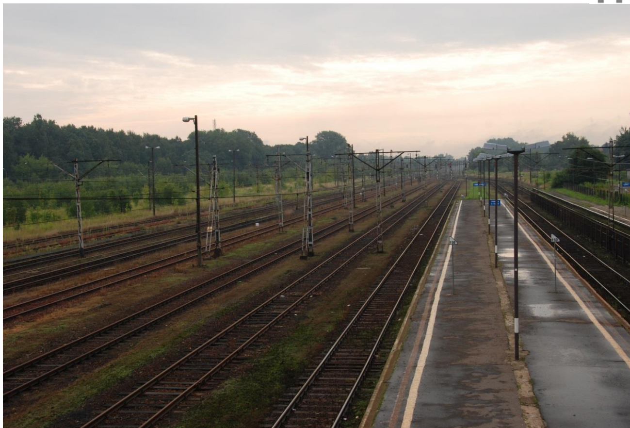
Rys 2 Stacja Łódź Widzew – peron wyspowy dwukrawędziowy wraz z układem torowym.
