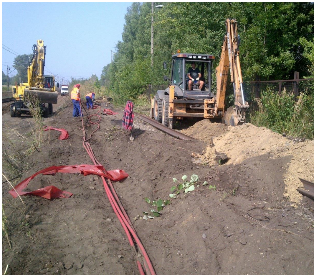
Rys 33 Usunięcie kolizji SN w km 7.200
