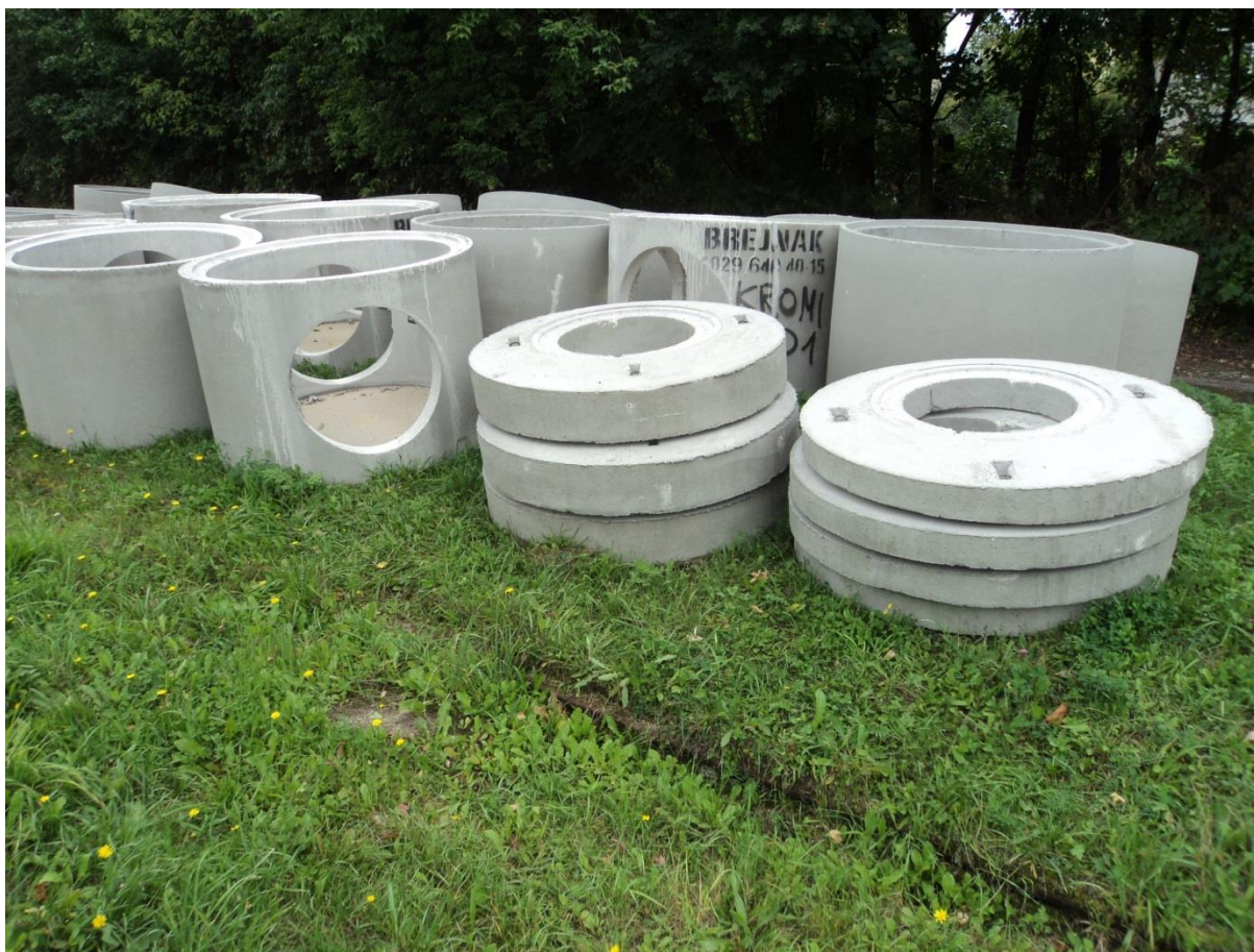
Rys 39 Studnie do budowy odwodnienia
