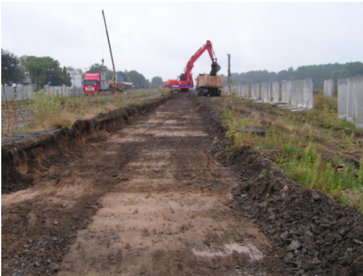
Rys 19 Wykopy pod ławy betonowe peronu nr 3
