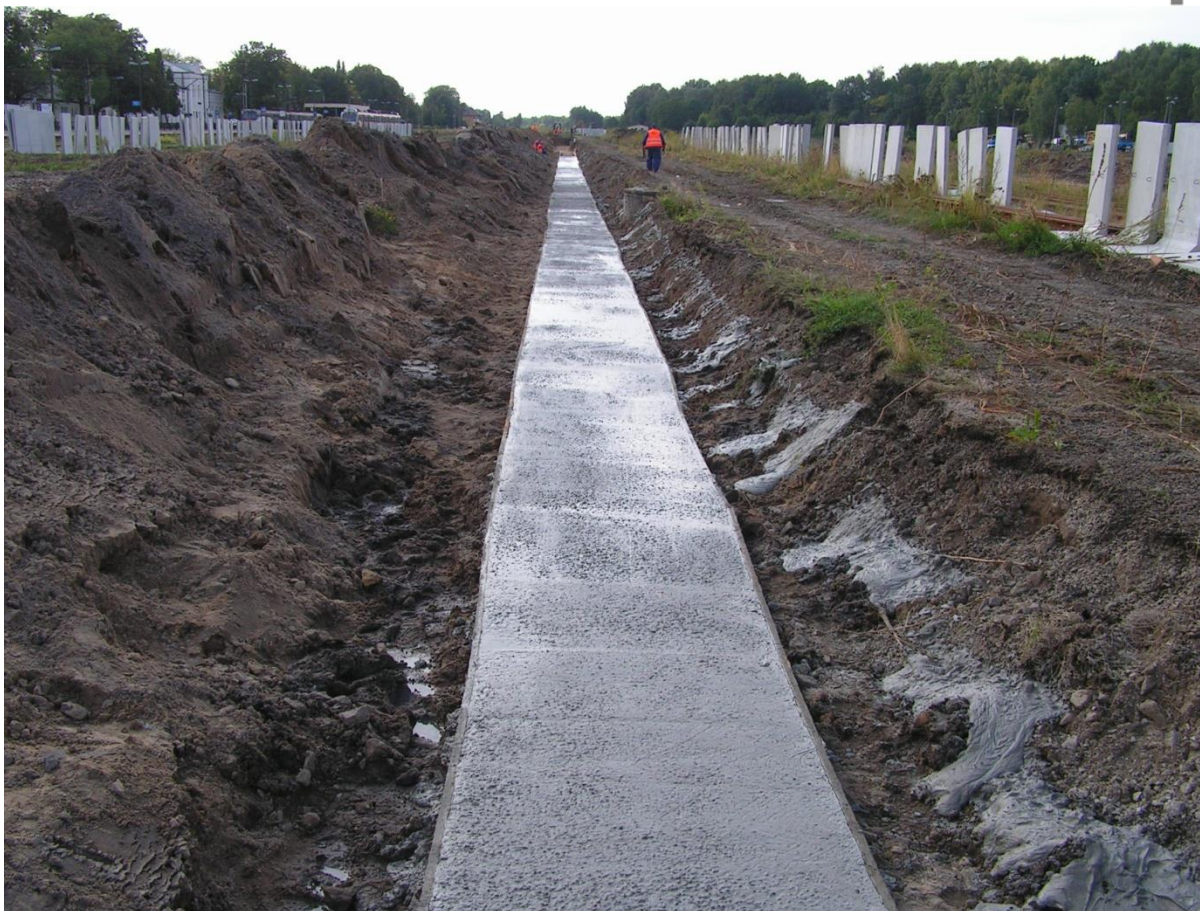
Rys 21 Zalewanie łąw betonowych peronu nr 3
