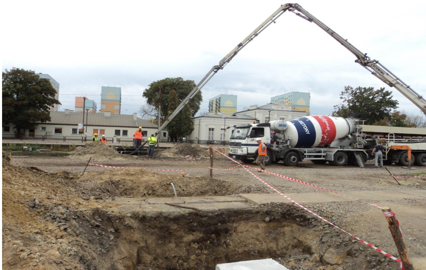
Rys 17 Zalewanie oczepów pali pod wiatę peronową
