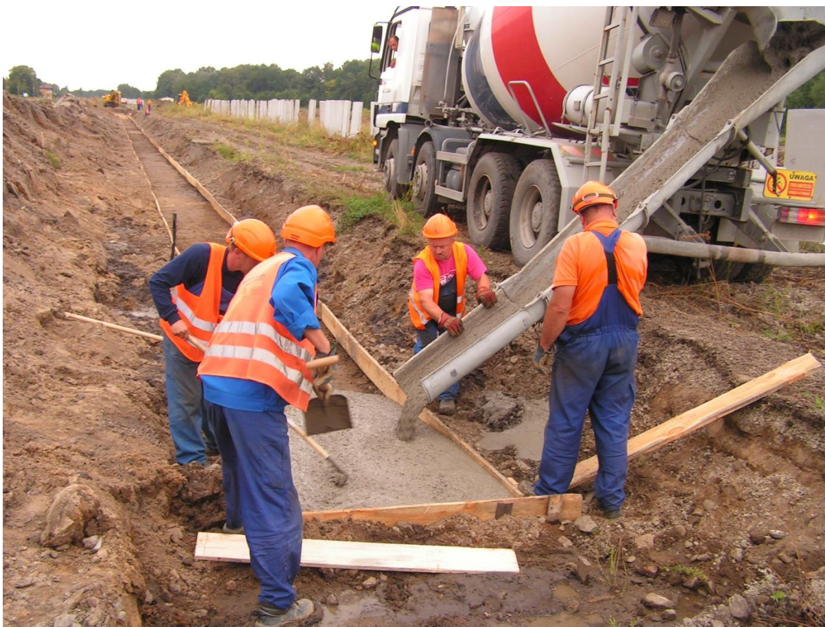
Rys 20 Wykonywanie szalunków pod ławy betonowe peronu nr 3
