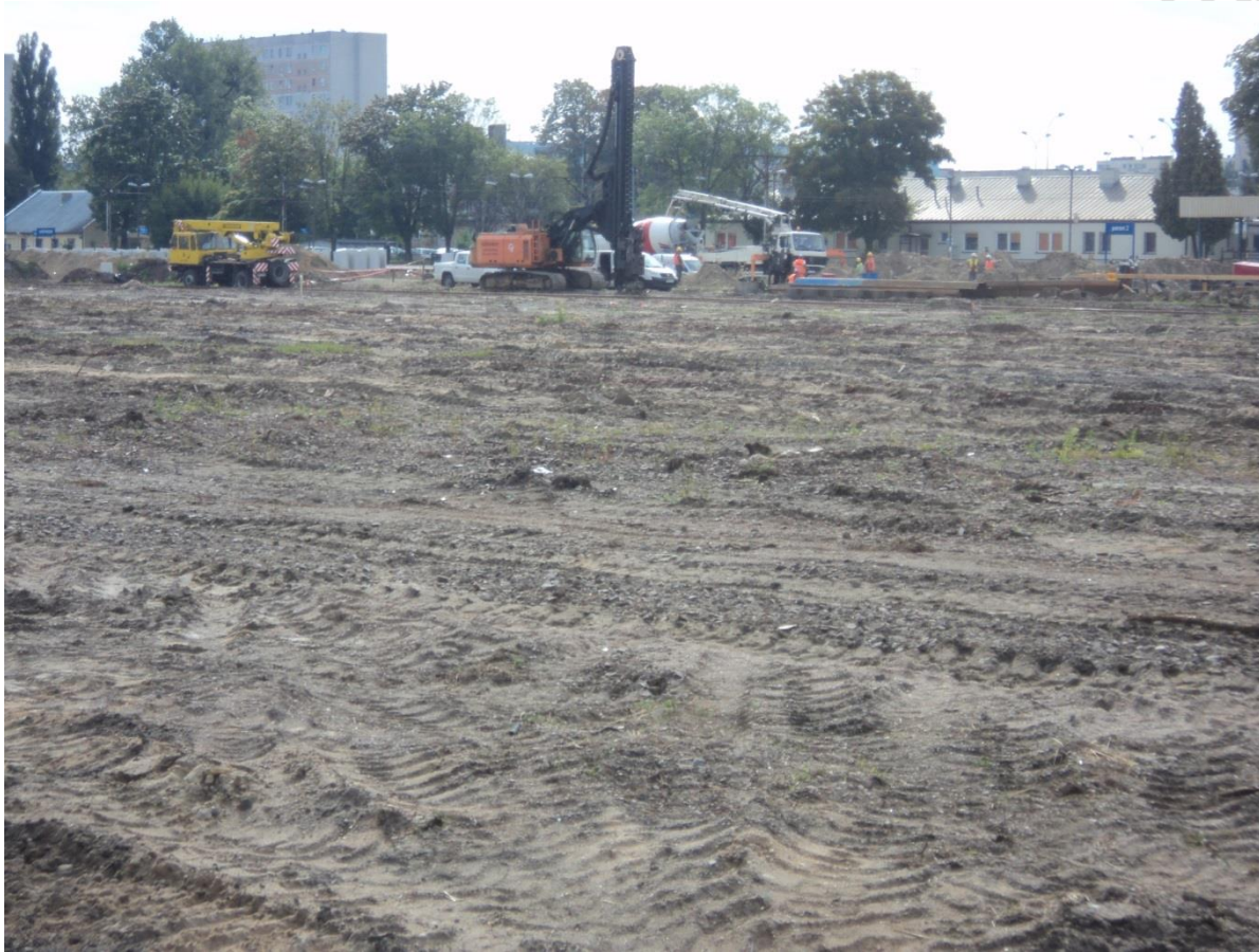
Rys 9 „Zabijanie” ścianek szczelnych przy użyciu kafara, na potrzeby budowy przejścia podziemnego dla pieszych na stacji Łódź Widzew.
