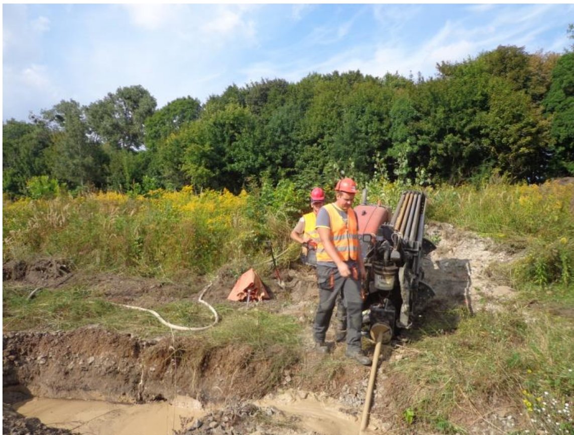
Rys 32 Przejście poprzeczne wykonywane przewiertem sterowanym
