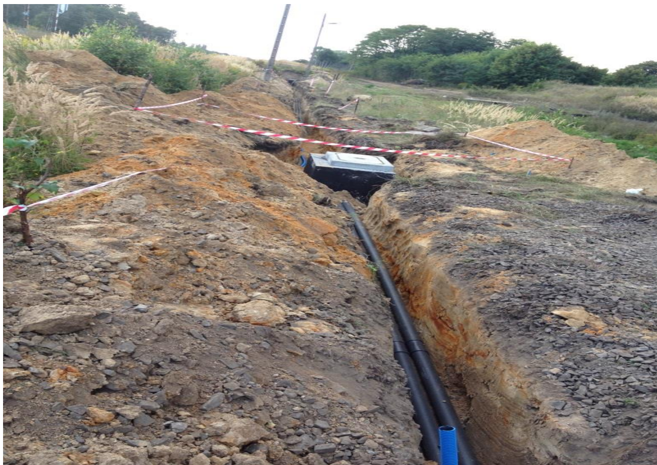
Rys 34 Wykonanie kanalizacji teletechnicznej i SRK wzdłuż linii kolejowej
