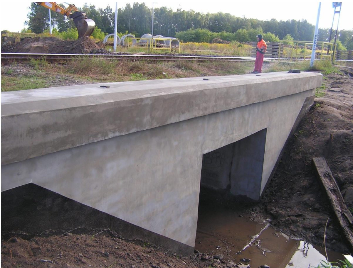
Rys 14 Wykonanie nowych przyczółków i gzymsów
