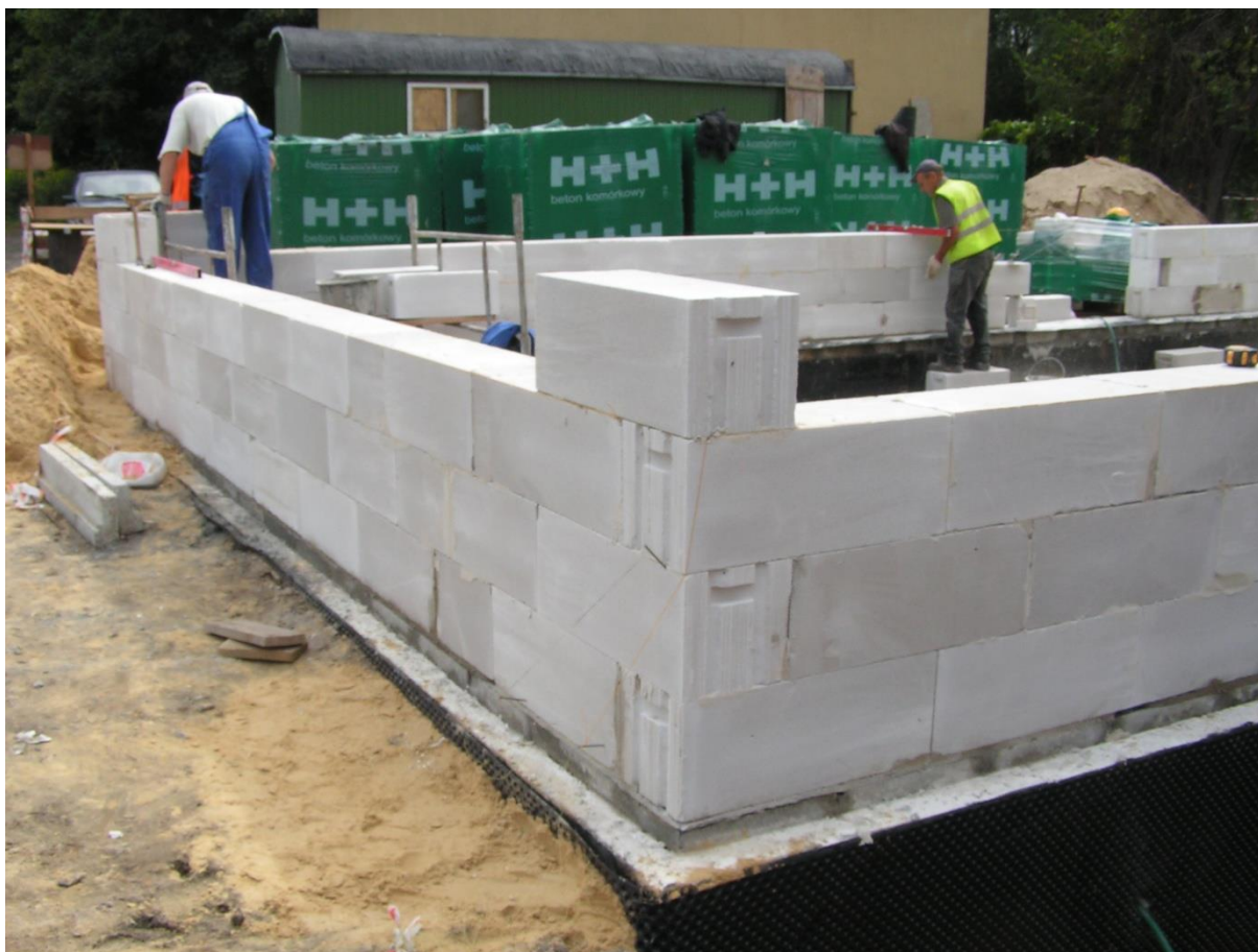
Rys 27 Dobudowa nowej części nastawni
