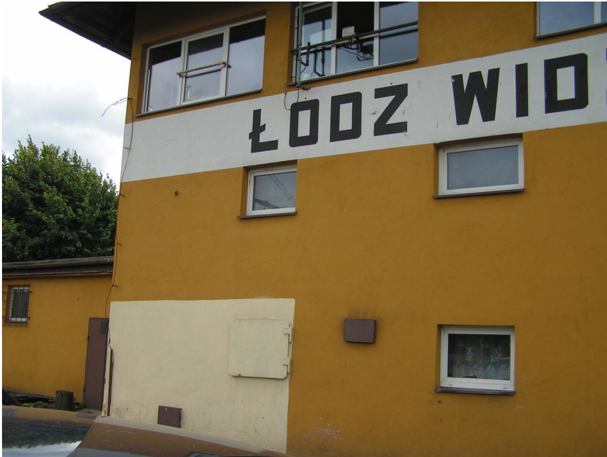
Rys 24 Nastawnia przed przebudową
