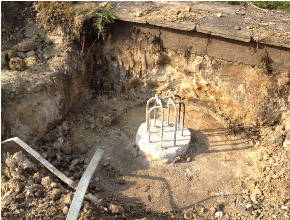
Rys 16 Wykonany pal pod wiatę peronową
