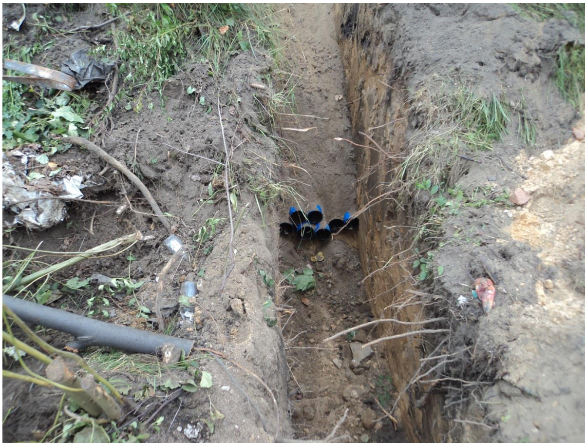
Rys 35 Wykonanie kanalizacji teletechnicznej i SRK wzdłuż linii kolejowej
