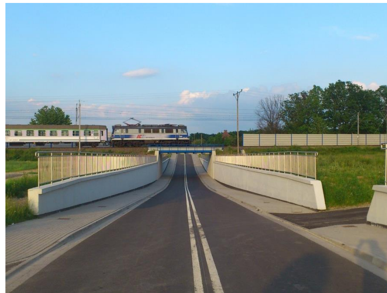
Wiadukt kolejowy w Osoli
