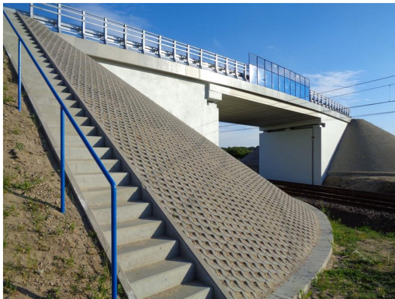
Wiadukt drogowy w Borowie
