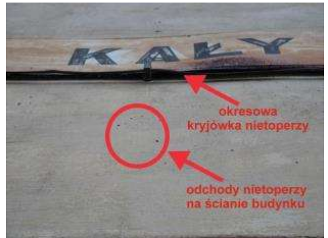
Foto 36. Kryjówka nietoperzy pod blaszaną tablicą i odchody nietoperzy na ścianie budynku stacji kolejowej Kały, LK 301, 24.08.2016.
