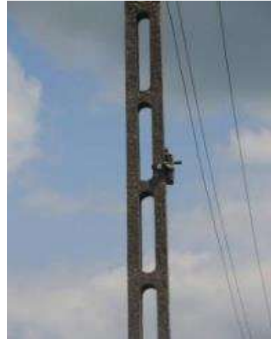
Detektor zamontowany na słupie przy kolei
