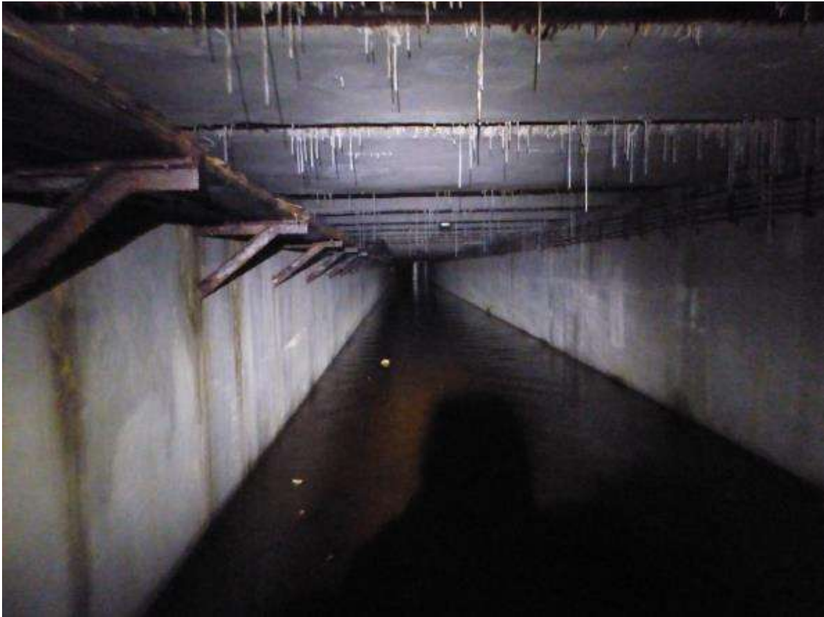
Foto 26. Tunel pocztowy – jeden z elementów podziemnego systemu bunkrów na obszarze stacji Poznań Główny. Elementy fortyfikacji na skraju stacji są wykorzystywane przez nietoperze jako miejsce hibernacji.
