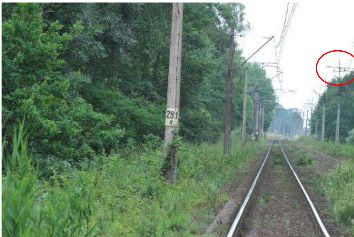
Fotografia 5-2 Odcinek 4 elipsą zaznaczono niebezpieczne elementy podane w literaturze
