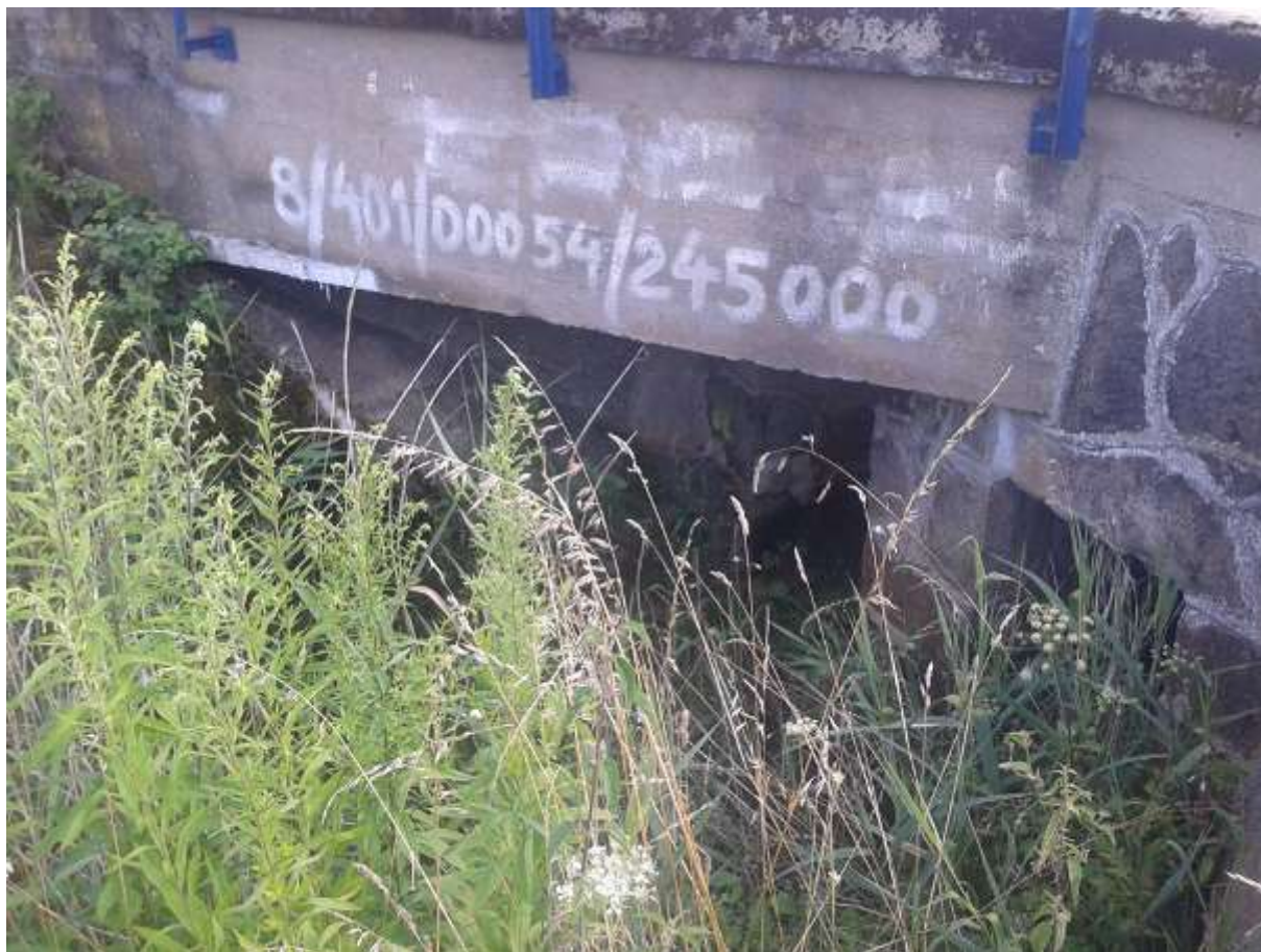
Fotografia 4-13 Przepust w km 184+270 - brak siedlisk płazów w pobliżu; monitorowany ze względu na potencjalne występowanie gadów
