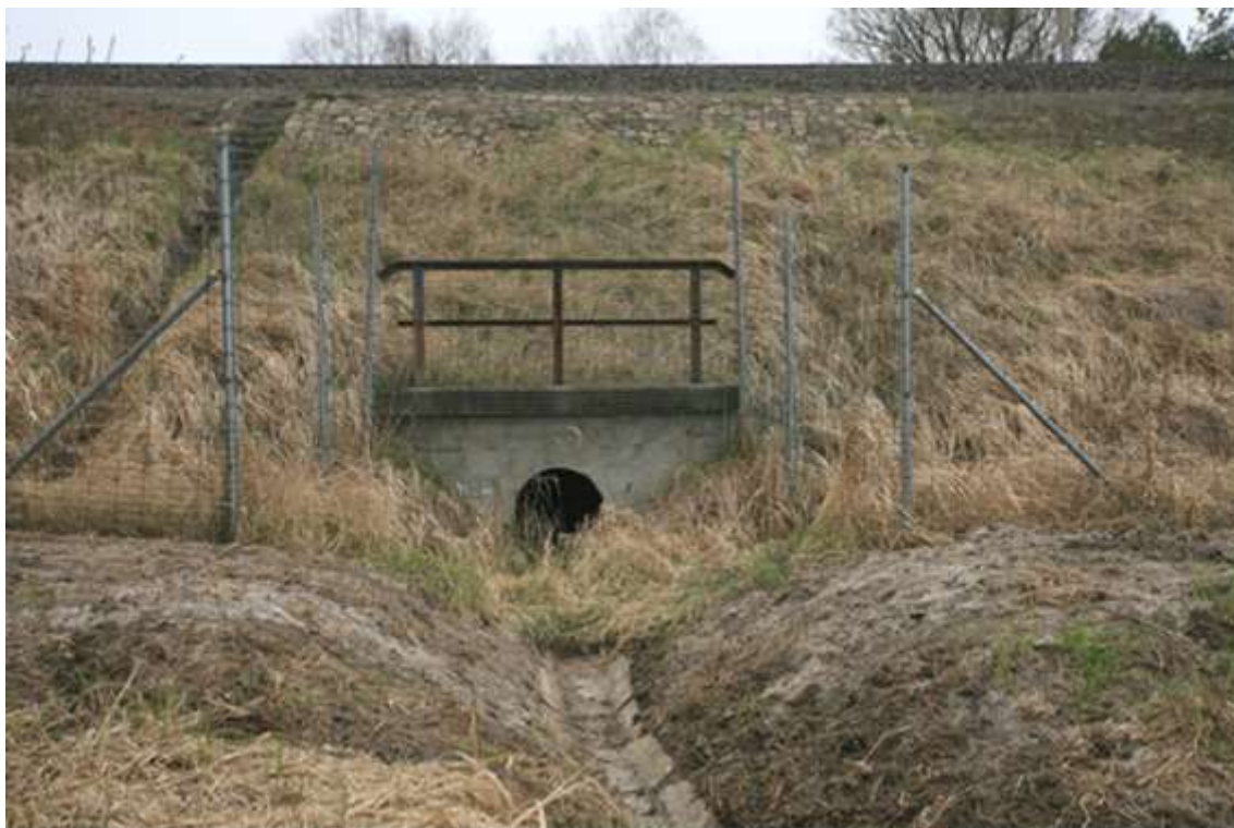
Fotografia 4-5 Przepust w km 467+974 w pobliżu siedliska ropuchy szarej
