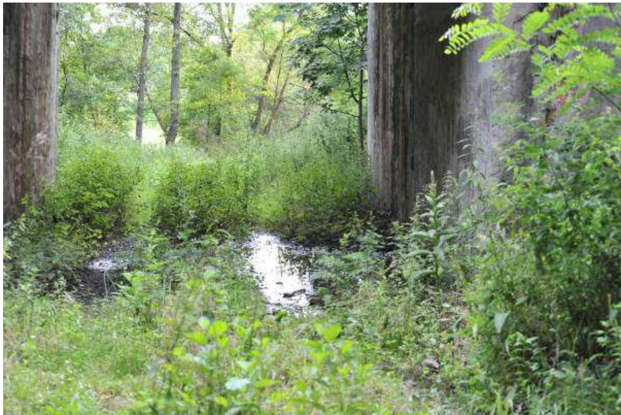
Fotografia 4-8 Obiekt w km 205+143 mogący ze względu na konstrukcję z powodzeniem pełnić funkcję przejścia dla płazów i gadów
