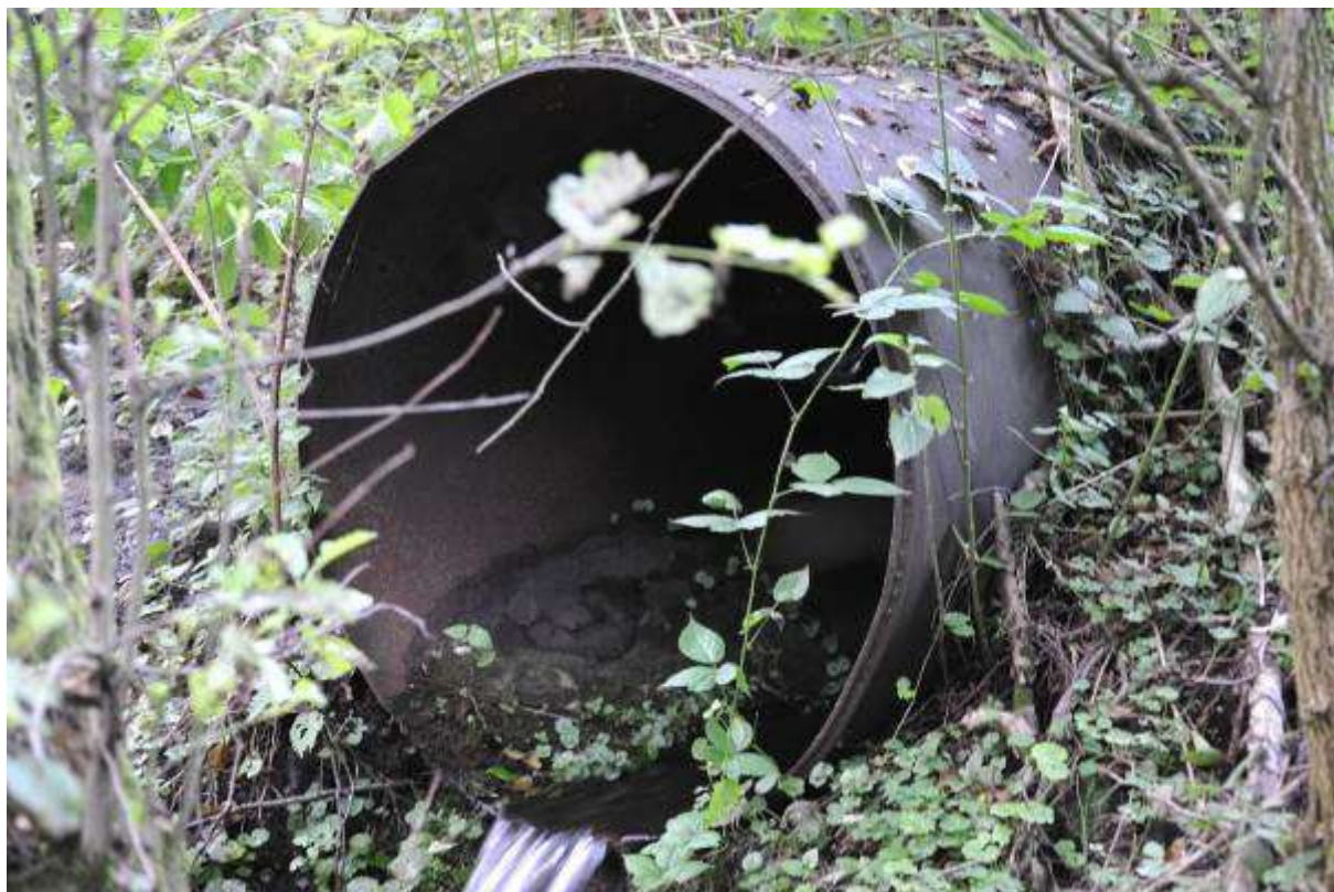
Fotografia 4-7 Przepust w km 205+061 - siedliska płazów znajdują się w pobliżu
