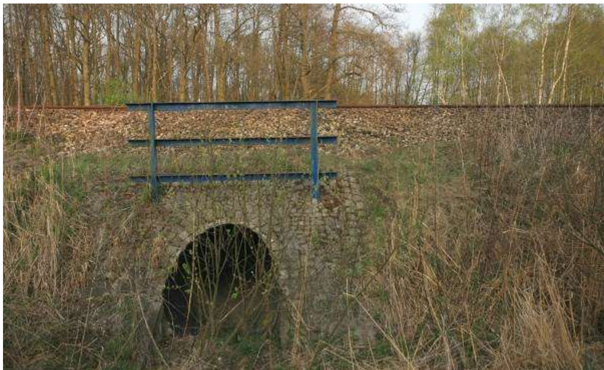
Fotografia 4-12 Przepust w km 296+781 monitorowany ze względu na potencjalną migrację gadów; siedlisk płazów w pobliżu brak
