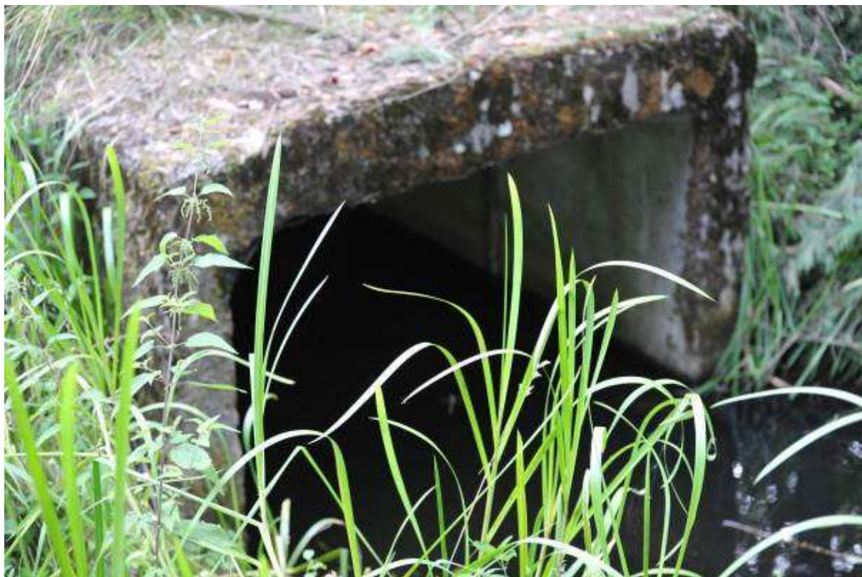
Fotografia 4-6 Przepust w km 204+834 przepust w pobliżu siedlisk płazów
