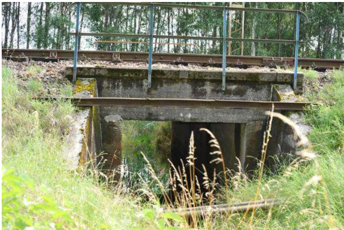
Fotografia 4-14 Przepust w km 185+740 położony w pobliżu siedlisk płazów
