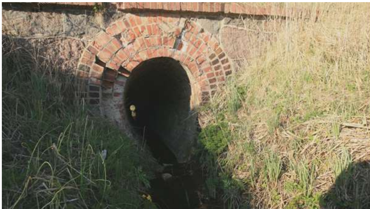
Fotografia 4-2 Przepust w km 416+905 w pobliżu siedlisk płazów
