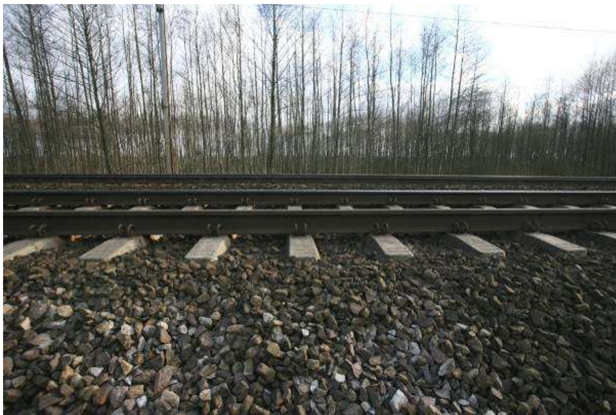
Fotografia 10-11 Odcinek 5 - niski nasyp i szczelina między podsypką i torami zapewniają możliwość swobodnej migracji
