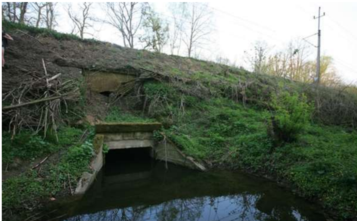
Fotografia 4-9 Przepust w km 291+174 (odcinek 4) w pobliżu siedlisk płazów
