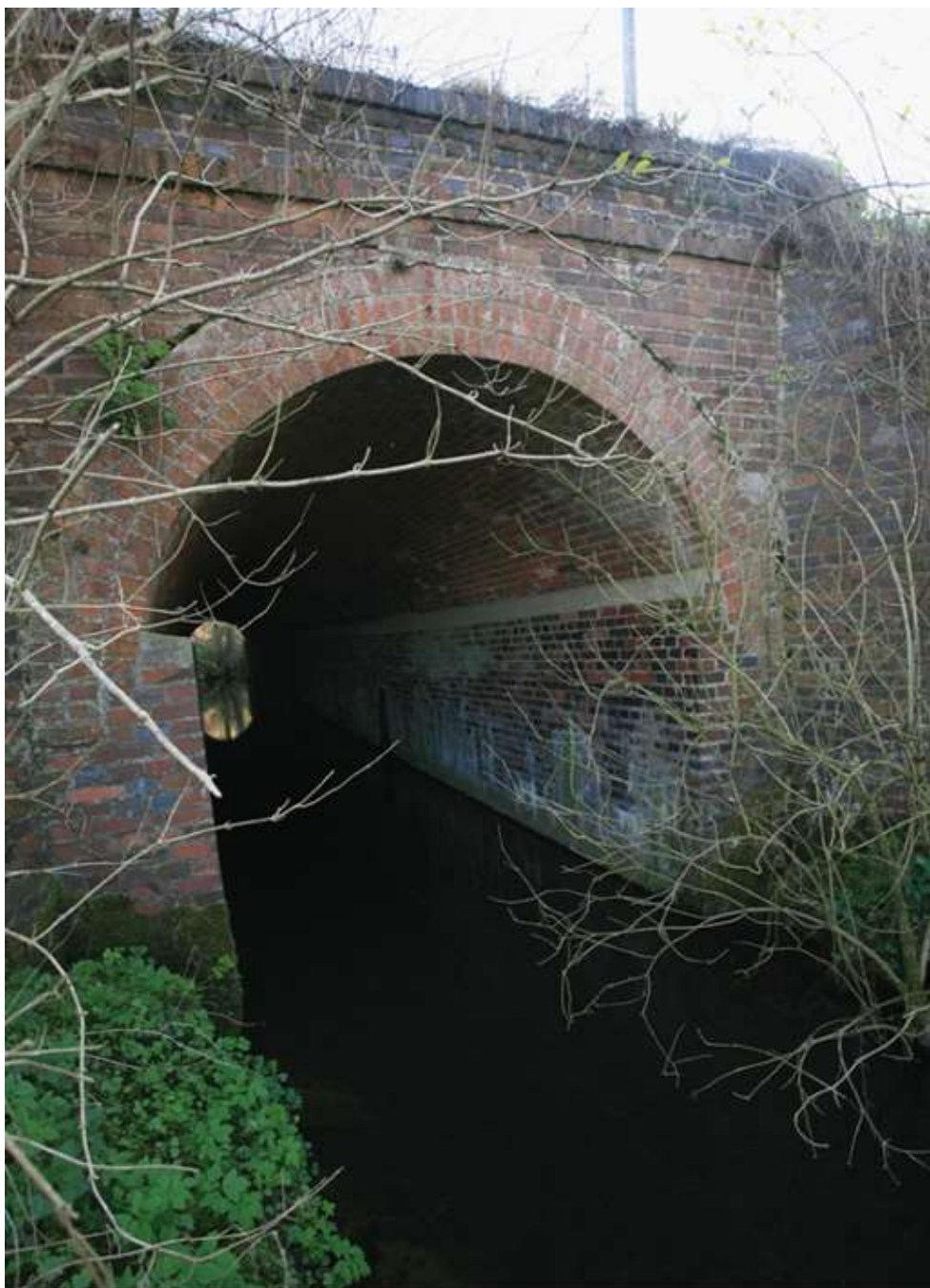
Fotografia 4-1 Przepust w km 416+553 (odcinek 1) w pobliżu siedlisk płazów
