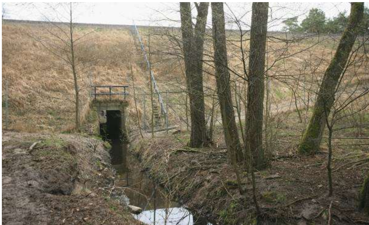
Fotografia 4-4 Przepust w km 467+246 położony w pobliżu siedlisk płazów
