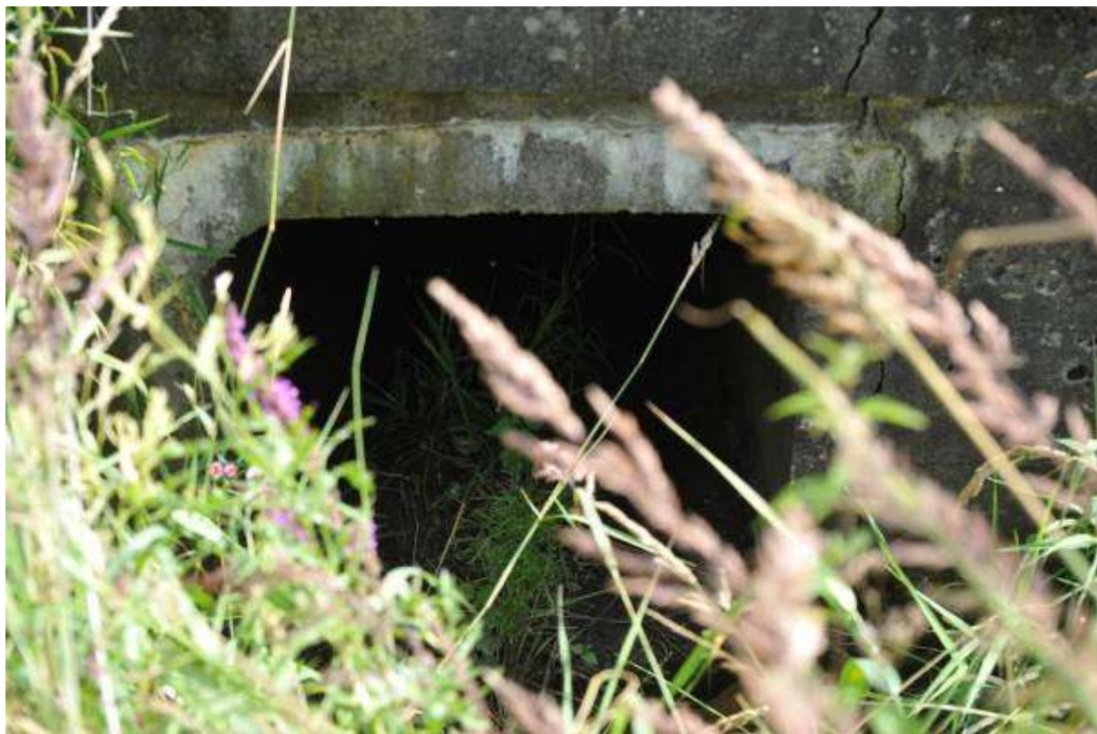
Fotografia 4-10 Przepust w km 292+168 w pobliżu siedlisk płazów i gadów
