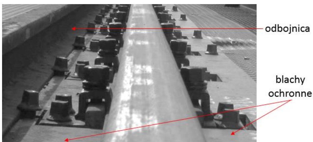
Rys. 11 Środki przeciwdziałające skutkom wykolejenia (przykładowe rozwiązanie)
