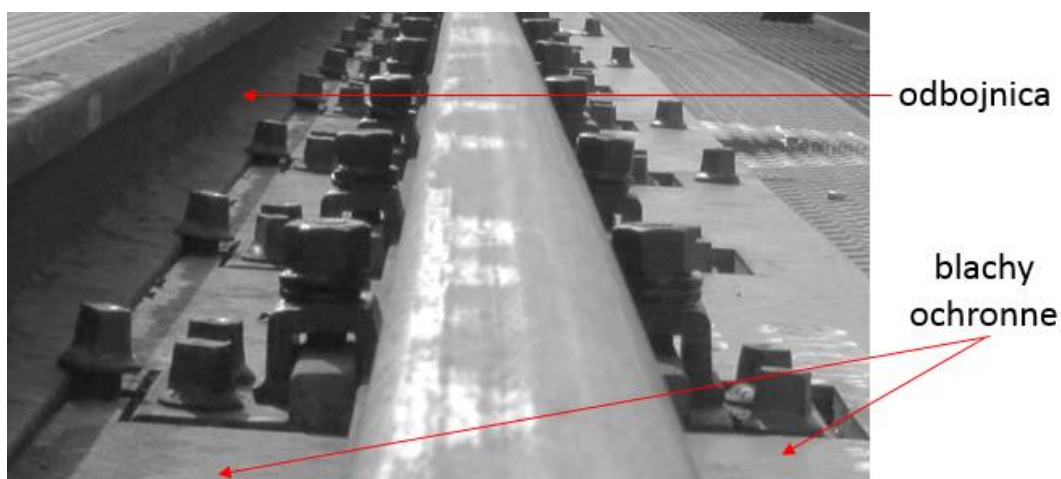
Rys. 11 Środki przeciwdziałające skutkom wykolejenia (przykładowe rozwiązanie)
